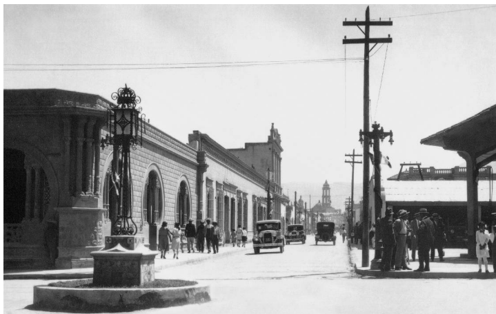
“Avenida Victoria” frente a la Alameda.
