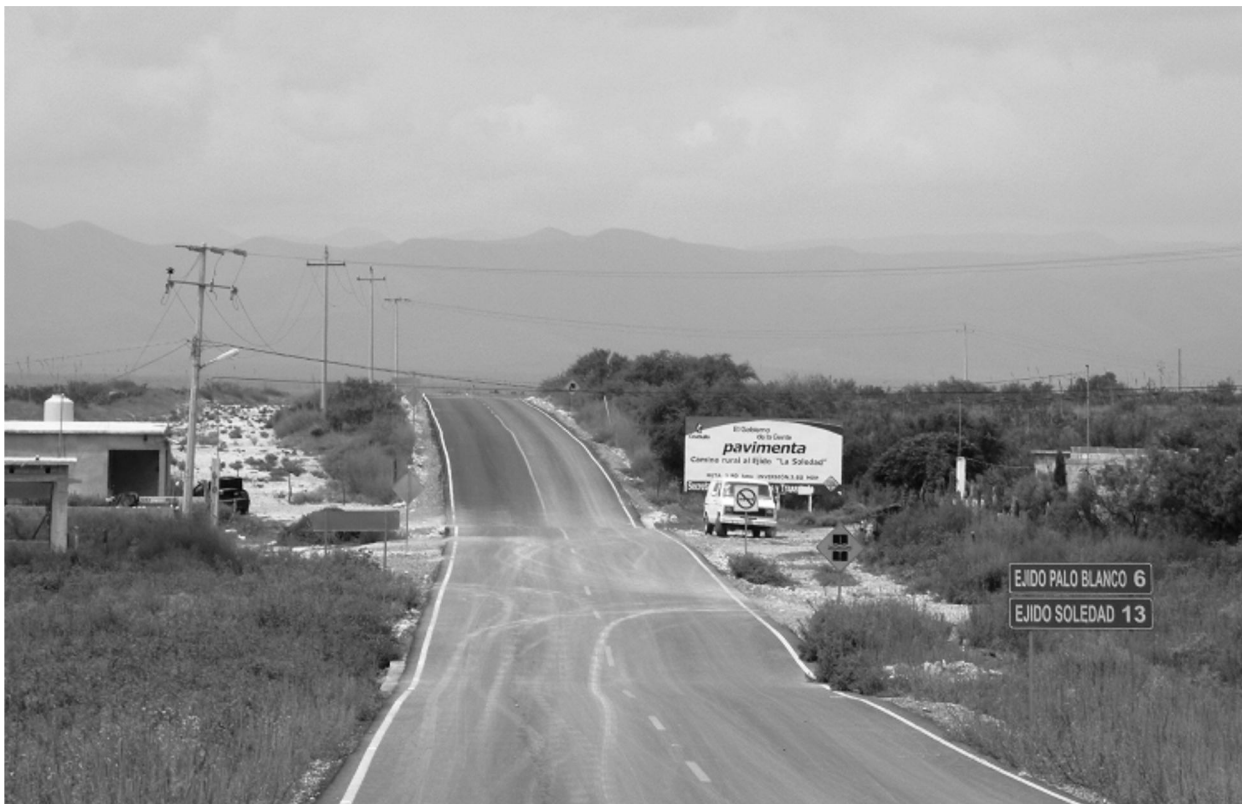
Nueva carretera Castaños-Palo Blanco-Soledad
