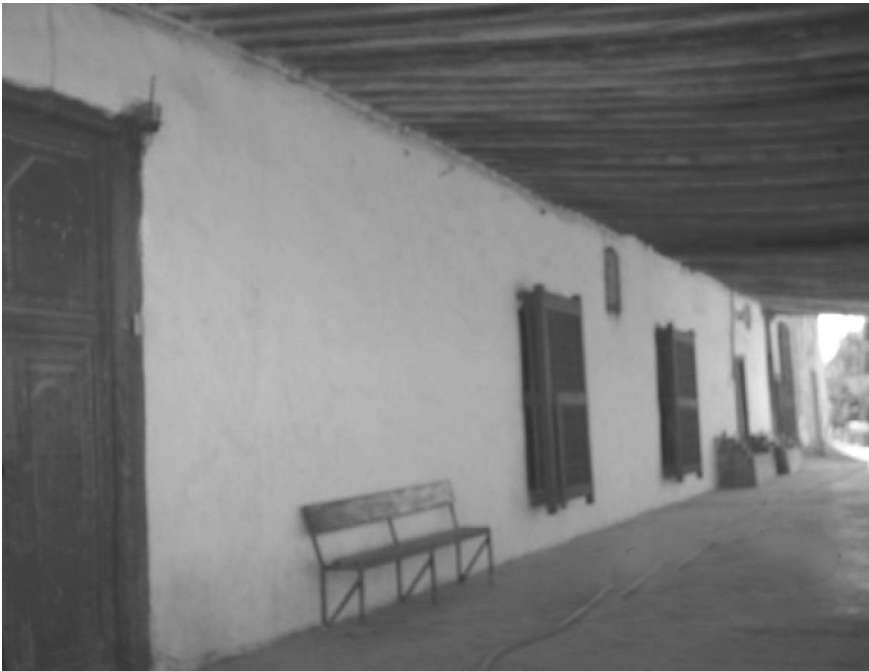
Ex hacienda de Santa María, a 6 km de la cabecera municipal de Ramos Arizpe.
