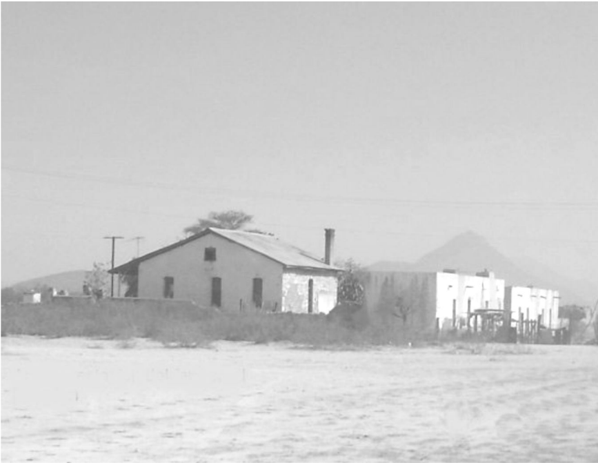
Antigua estación del ferrocarril Paredón.
