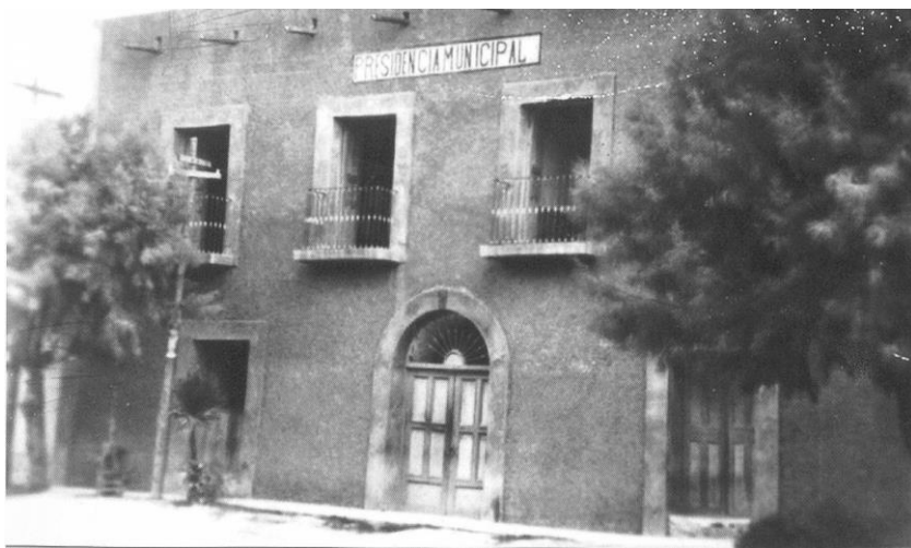
La antigua Presidencia Municipal estaba ubicada donde actualmente se encuentra el nuevo edificio destinado a esos mismos servicios públicos.
