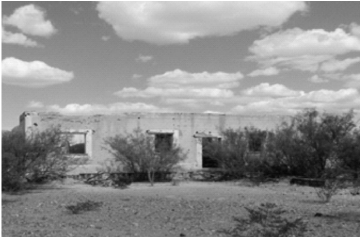
Estación de Bandera San Carlos, Coah. Km 104
