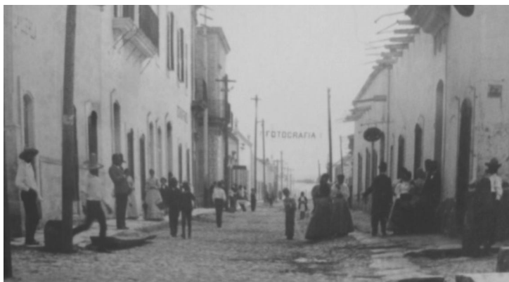
Calle Juan Antonio de la Fuente. Advértanse los segundos pisos con balcones voladores, las escurrideras en los techos y las baldosas peatonales en la bocacalle. Fotografía ca. 1920. Fototeca AMS.
