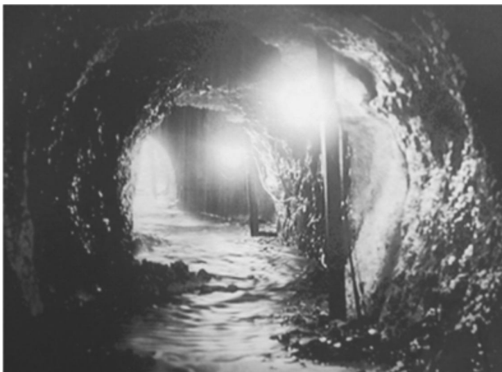
Galería filtrante en Buenavista. Dirección General de Catastro. Fototeca AMS, Fotografía, año de 1972.
